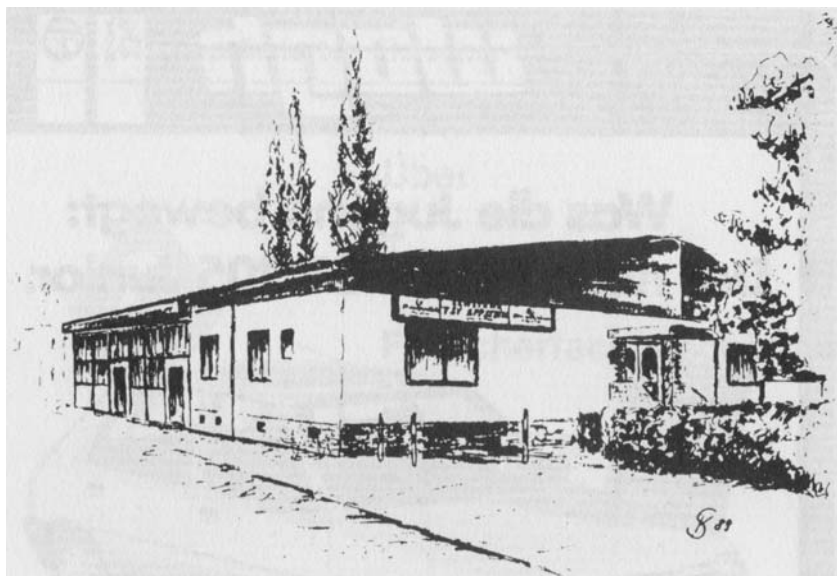
Außenansicht der Vereinsgebäude des TSV Eppstein
